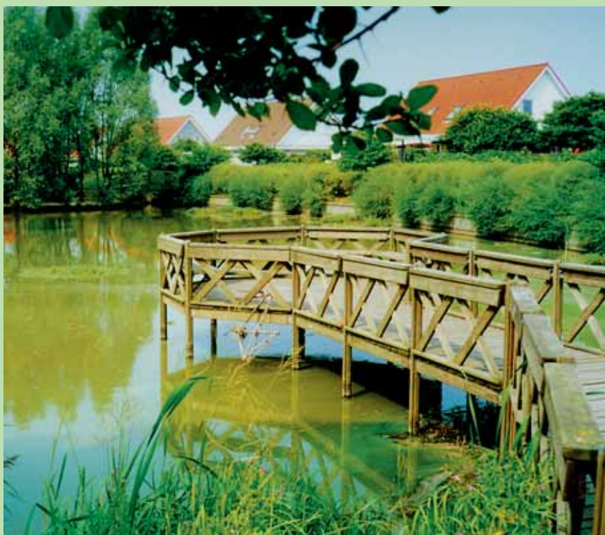
Regnvandsbassin. Bemærk den lodrette kantafrænsning som er sikret med buske. Allerede ganske få år efter anlæggelsen havde der indfundet sig fisk i søen. (Foto: Kim Tang)
