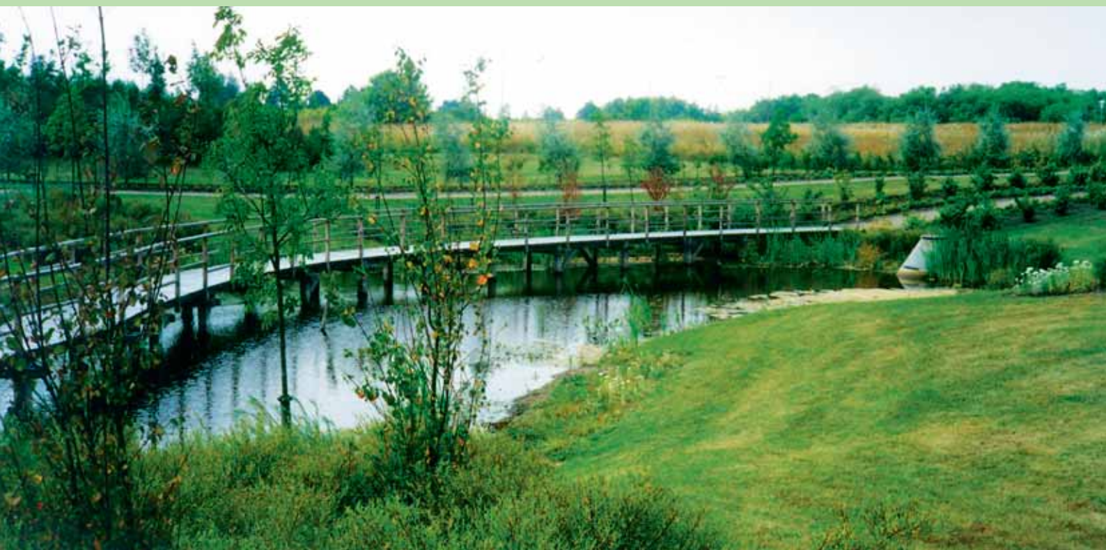
Lavning i terrænet var planlagt som rørsump med en lang bro igennem. På grund af stor tilledning af vand har der indfundet sig et frit vandspejl. Med den valgte udformning er der mulighed for stor variation i vandstanden. (Foto: Kim Tang)
