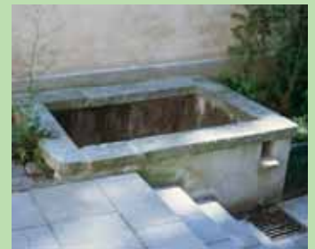
Stort trug til opsamling af vand som bl.a. bruges til vanding. Bemærk overløb til kloak. (Foto: Kim Tang)
